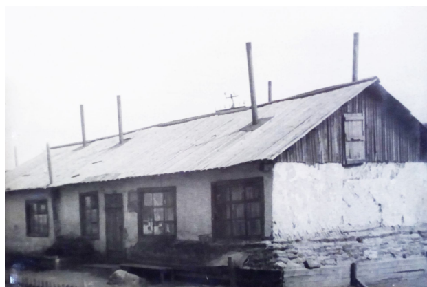
Первое здание ВНИМС в пос. Рудник [13, л. 9]. The first building of VPRS in the village of Rudnik [13, l. 9].
